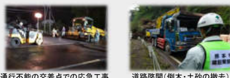
通行不能の交差点での応急工事
